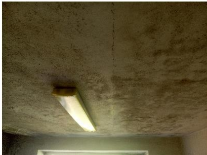
Рис.2 Пошкодження плит перекриття душової та кухні
