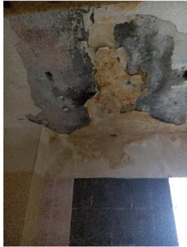
Рис. 1 Фотофіксація дефектів оздоблення фасаду та стелі
