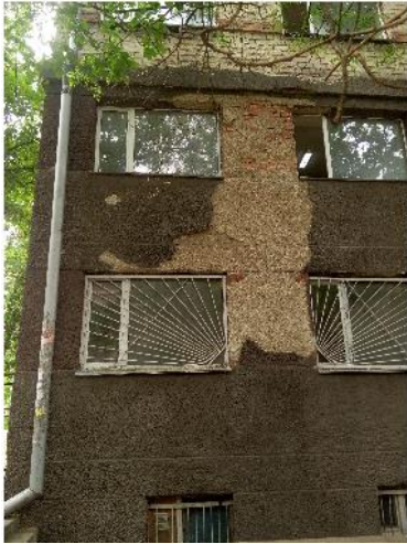
Рис. 1 Фотофіксація дефектів оздоблення фасаду та стелі
