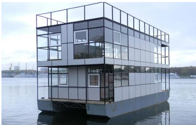
Рис. 3. Будівля на металевому понтоні
