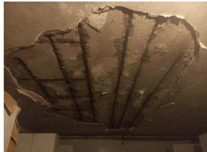
Рис.2 Пошкодження плит перекриття душової та кухні
